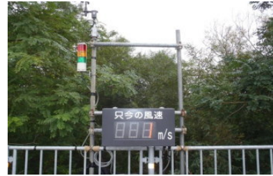
風速計(表示板付)設置 (川溪流保)
