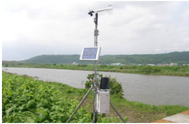
風向風速・水位・雨量計設置 (橋梁解体工事)
