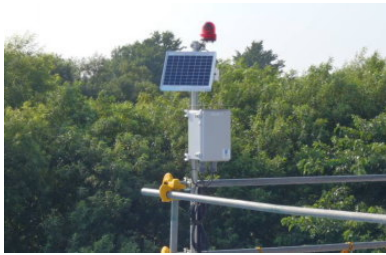
水位計設置 (河川改修)
